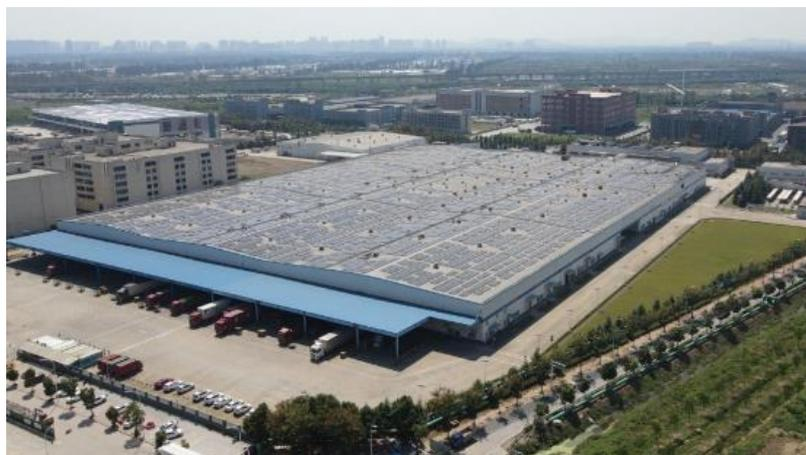
图 4：脉动武汉工厂太阳能屋顶
