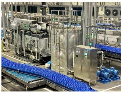
图 5：吸收式热泵机组
